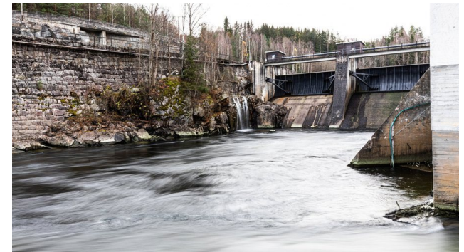
Norwegen erzeugt nahezu hundert Prozent seines Strombedarfs aus Wasserkraft. Im Bild: das Kraftwerk Ulefoss.
